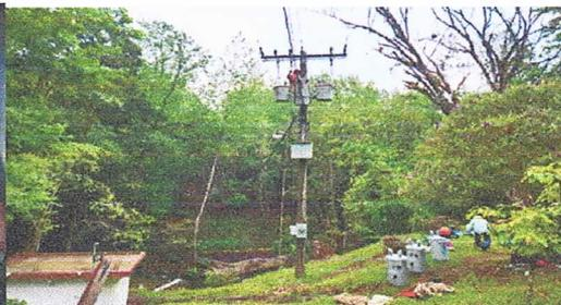
TRANSFORMADORES ELECTRICOS DE 25 KVA (kiovoaltampere) linea 13,200 240/480 voltios impedancia de 2.8
